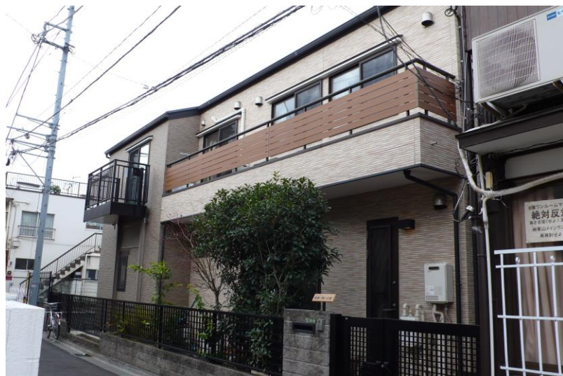
文京区千石のグループホーム
