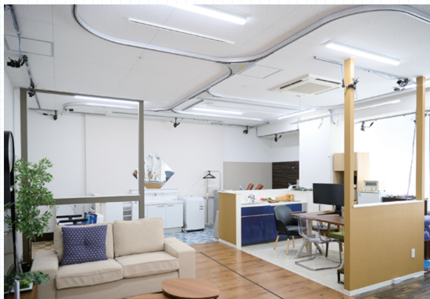
方向転換を可能にする分岐レールを設置
