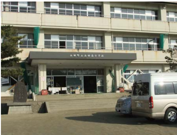
避難所となっている小学校
