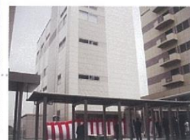
バイオバンク棟
