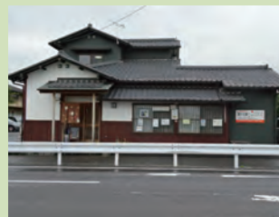
▲あい工房 外観
